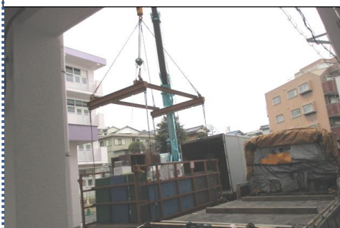
クレーンで4階まで吊り上げ、教室へ運んでいました。とても大変そうでした。
