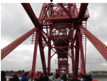
筑後川昇開橋
