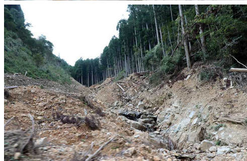
急ピッチで行われる河川敷復旧工事
