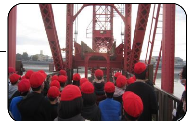
筑後川昇開橋
