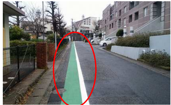
【グリーンベルトの設置】
