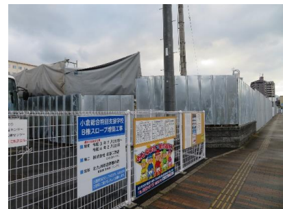
旧総合療育センター西棟解体工事
