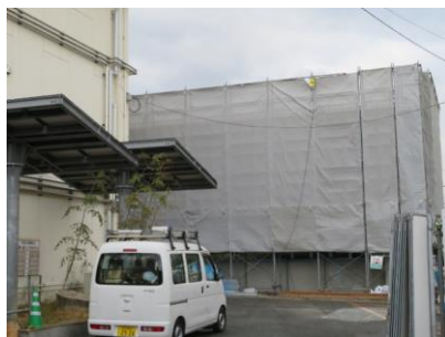
B棟スロープ棟増築工事
