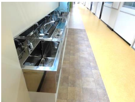
ステンレス製の手洗い場と明るく なった廊下
