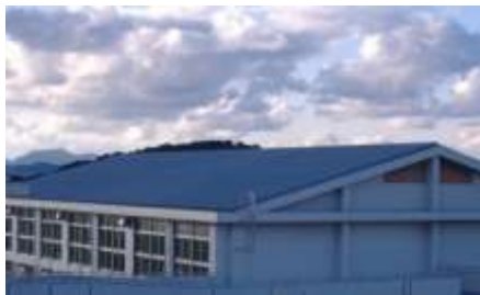
雨漏りしていた体育館の屋根の改修工事をしていただいて新品に！
