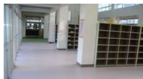
あちこち傷んでいた昇降口は、全面張り替えていただきました。
